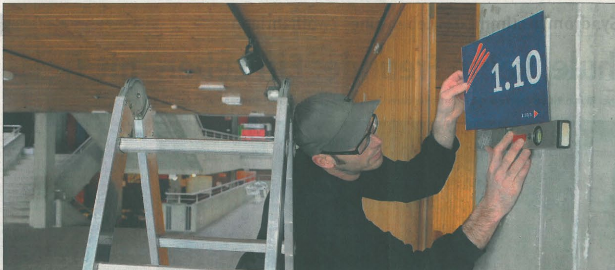
Kai Bohn von der Firma „Schrift und Farbe digital“ montiert mit seinen Kollegen die neuen Schilder in der Rumold-Realschule.
